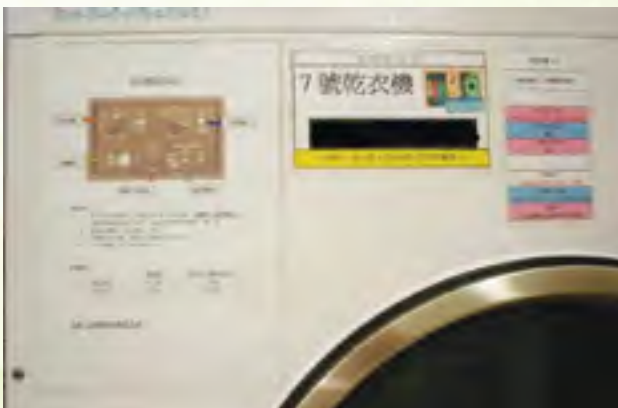
· 現場機器操作指引
